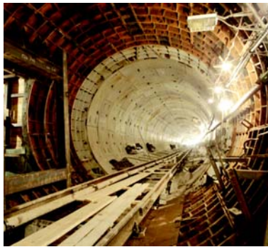
Левый перегонный тоннель между станциями «Шипиловская» и «Борисово».
