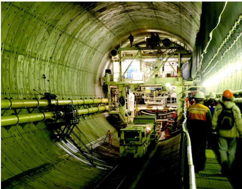
ТПМК в тоннеле.
