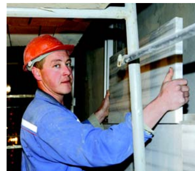
Р. О. Резванов монтирует путевую стену.
