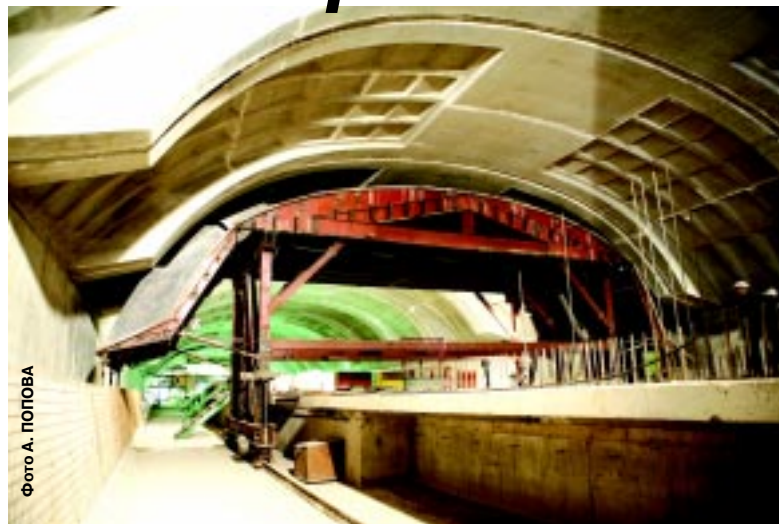
С этой передвижной опалубкой строители СМУ-13 забетонировали свод на две недели раньше срока.
