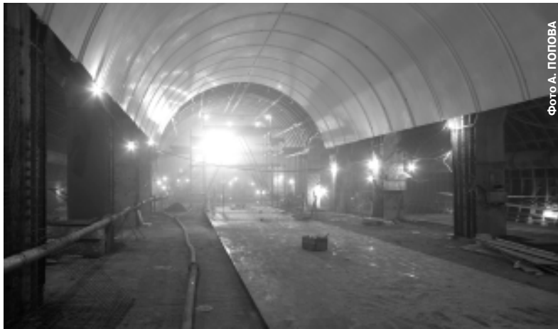
На станции «Трубная площадь» идут отделочные работы.
