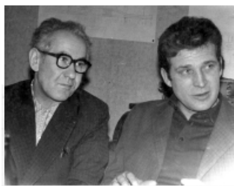
Участковый маркшейдер П.Е. Прессман (слева) и начальник участка В.А. Матякин во время строительства станции «Полянка».
