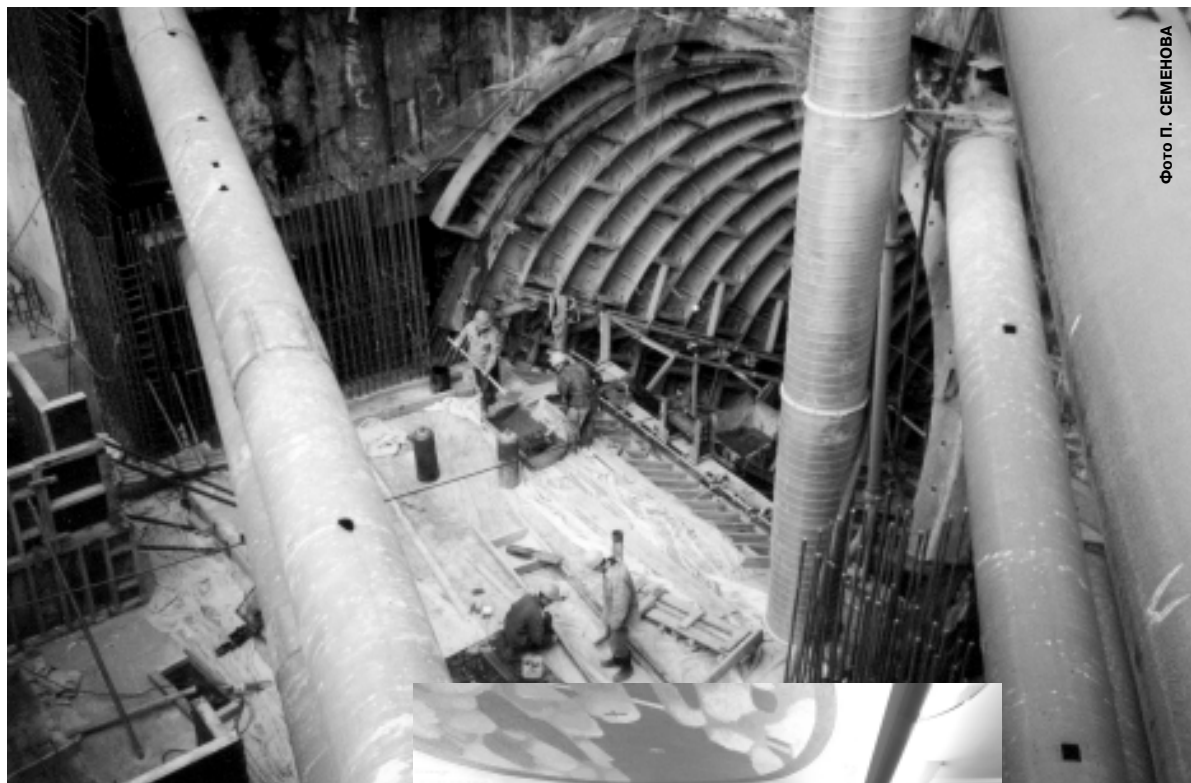
На строительстве вестибюля и наклонного хода станции «Трубная».
