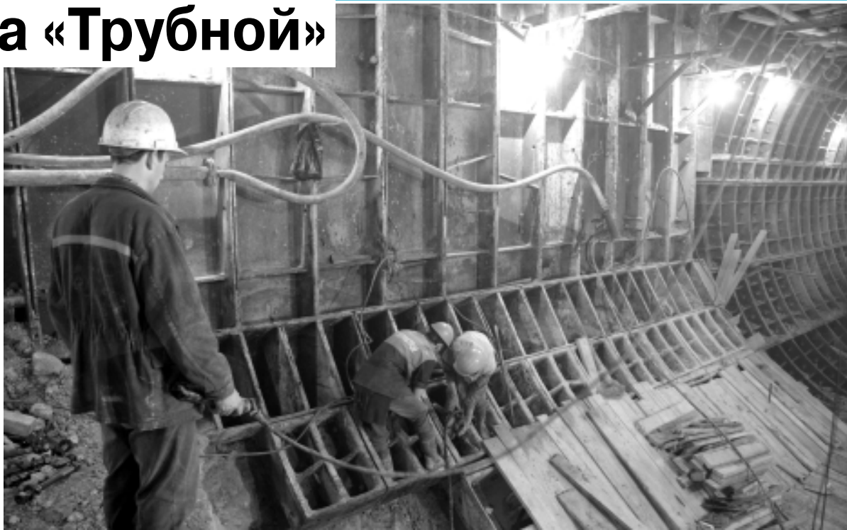
Идет монтаж тубингов обратного свода для ВОУ.
