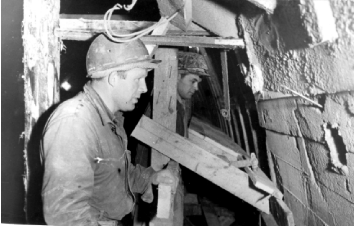
Иван Газин с другом Владимиром Рыковым на строительстве станции «Октябрьская».
