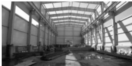
Пока без крыши, окон и кран-балок...
